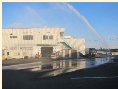
(屋外消火栓放水)
